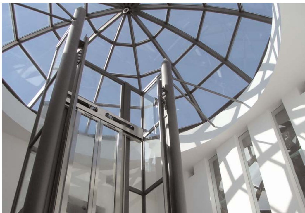
Ein weiteres gestalterisches Highlight stellt die auffällige Glaskuppel mit einem Durchmesser von 5,5 m dar, die das rote Dach des Hauses krönt und seinen Mittelpunkt bildet. Sie erzeugt eine enorme Lichtdurchflutung und sorgt so für interessante Licht- und Schattenspiele im Gebäude
