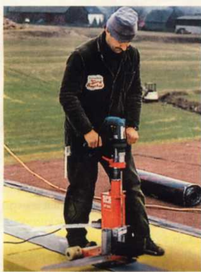
Fot. 4. Mechaniczne mocowanie papy śrubami wkręcany automatem
